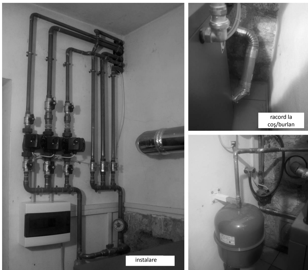
Figura 14: Exemplu de centrală termică
