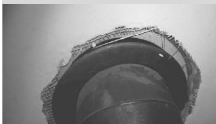
Racordare necorespunzătoare a racordului și fără dilatarea tubului de racordare
