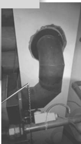
Racordare necorespunzătoare a racordului și fără dilatarea tubului de racordare
