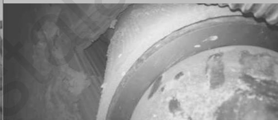
Conectare greșită a conductei de gaze arse și nu există nicio dilatare a absorbției de fum
