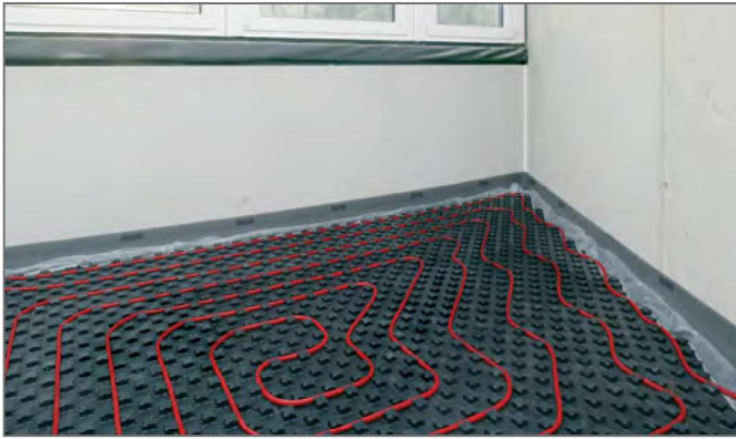
Fig. 3-11 Sistemul REHAU Placa cu nuturi Varionova cu subizolație fonică de tip 30-2
